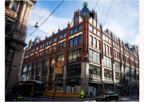
Aleksi 13 -talon remontti on lähes valmis.
