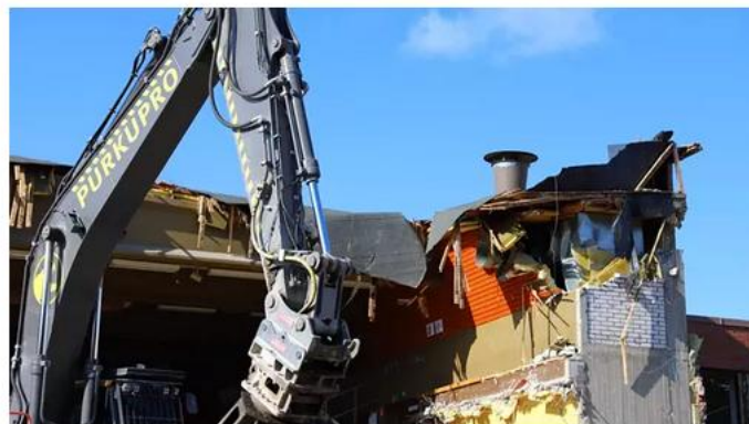
Nokian palloiluhallin purkaminen on alkanut. Kattopellit, villat, laudat ja tiilet saavat kyytiä.
