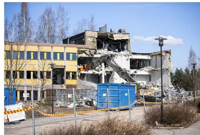
Tampereen Kalevassa sijaitsevan Hippostalon ulko-osien purkaminen alkaa matalimmasta osasta. Tältä purkutyöt näytrivät keskiviikkona 21. huhtikuuta. KUVA: TONI REPO / AAMULEHDEN ARKISTO
