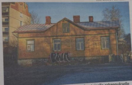
Kaupunki päätti antaa purkuluvan huonokuntoiselle rakennukselle helmikuussa 2024.
